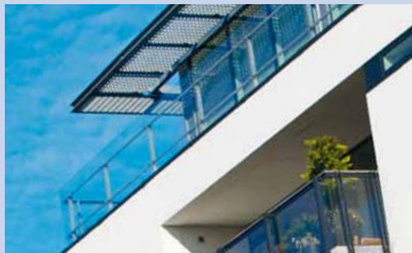
Se till att underhållsansvaret för tillbyggnader är reglerat.
