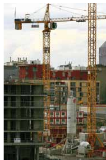
Under 2010 påbörjades byggande av 13 000 nya lägenheter i Sverige.
