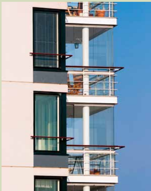
Inglasning av balkonger ses som en ombyggnad av huset. En stämman måste därför fatta beslut om förändringen kan bli av eller inte.
